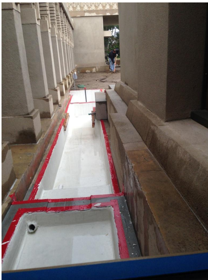
بازسازی تونل زیرزمینی هدایت آب از استخر به حوضچه شومینه
