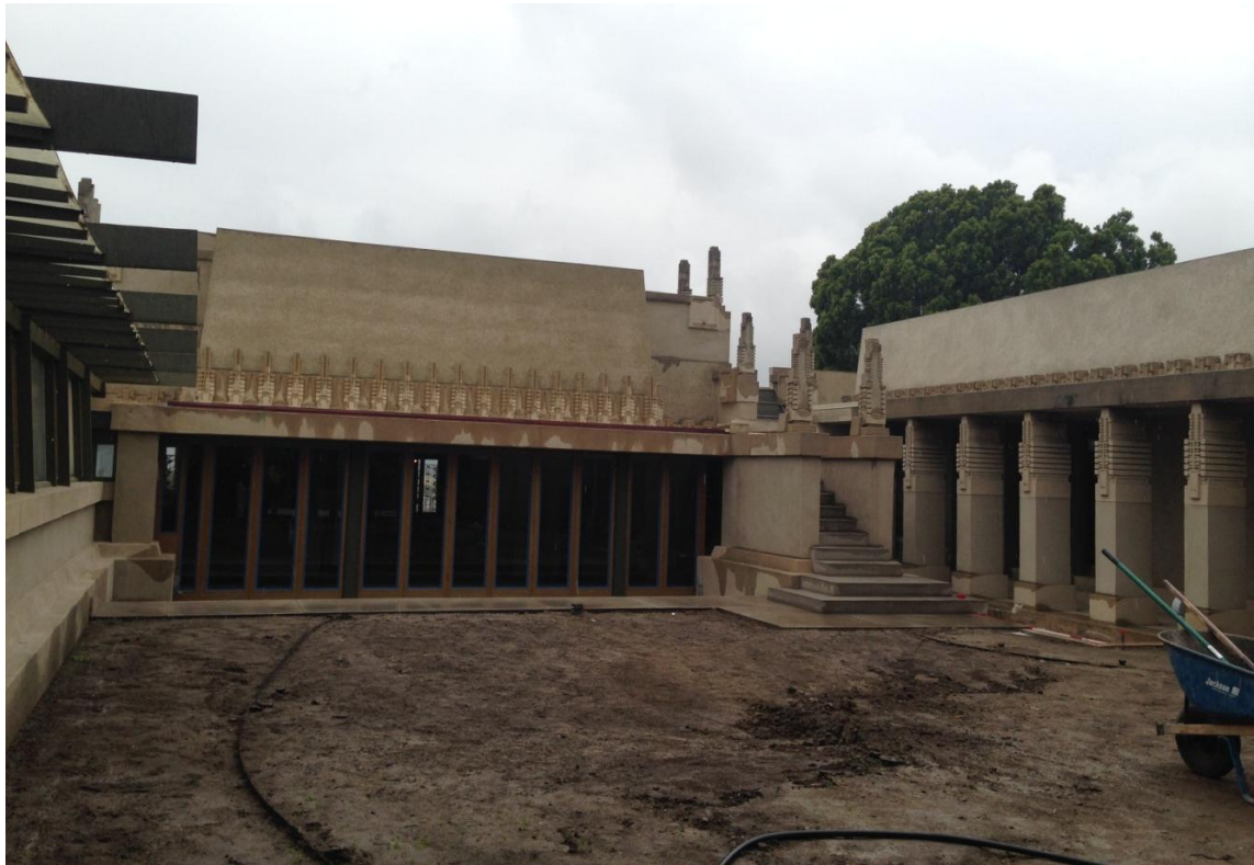
حیاط مرکزی خانه در حال بازسازی
