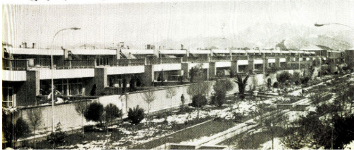
نمایی از ساختمانهای کوی فرح
