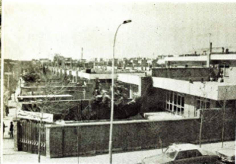
نمایی از ساختمانهای کوی فرح
