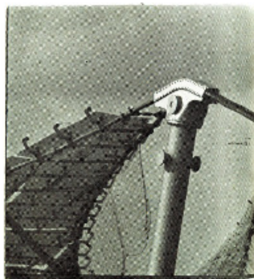
قسمت انتهای یکی از دکل‌ها
