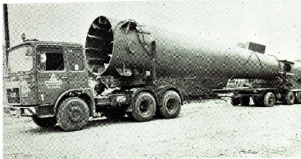
Transport d'une partie d'un des pylônes destinés à supporter le toit translucide
