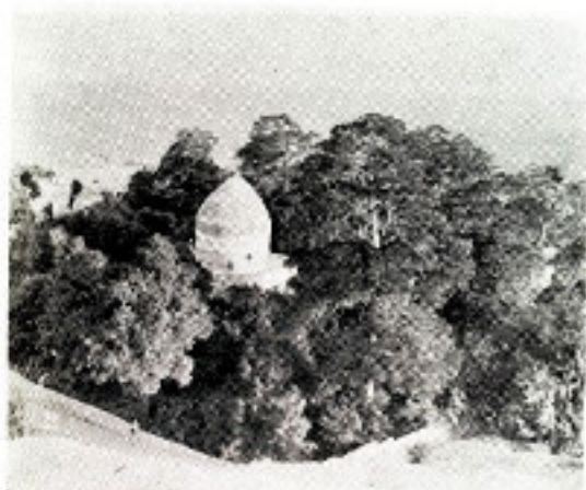
Vue d'un Imam - Zadeh (lieu saint) Chémiran
