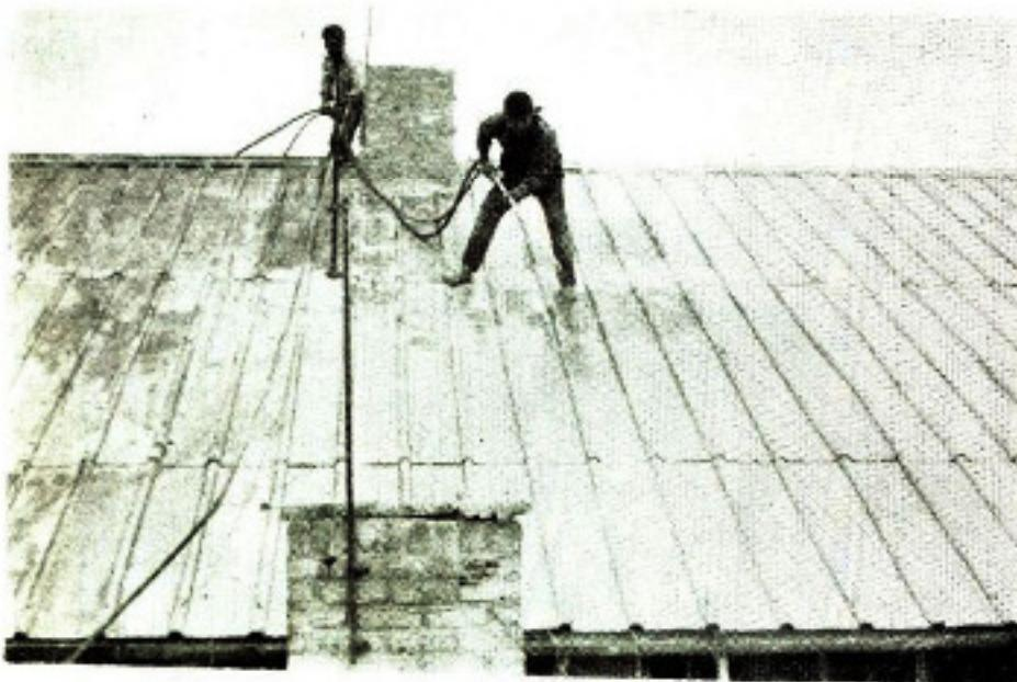
در بالا شیرواپیهای منازل کارگری خوزستان با ماده فورسیزن عایق گردیده‌اند اختلاف شیرواپی قبیل از تعمیر و بعد از تعمیر کاملاً مشاهده میشود. تغییض شیرواپیهای زنگ زده علاوه بر مخارج گراف بعاتسکوونت مشکل است، با استفاده از فورسیزن شیرواپیهای زنگ زده با مخارج مختصر تعمیر و بعدت ۱۰ سال تضمین میگردد. فورسیزن علاوه بر تیمال که به شیرواپی میبخشد بعلت رنگ الی مینیوم خود حرارت را به میزان قابل توجهی در ذیر شیرواپی تقلیل میدهد.
