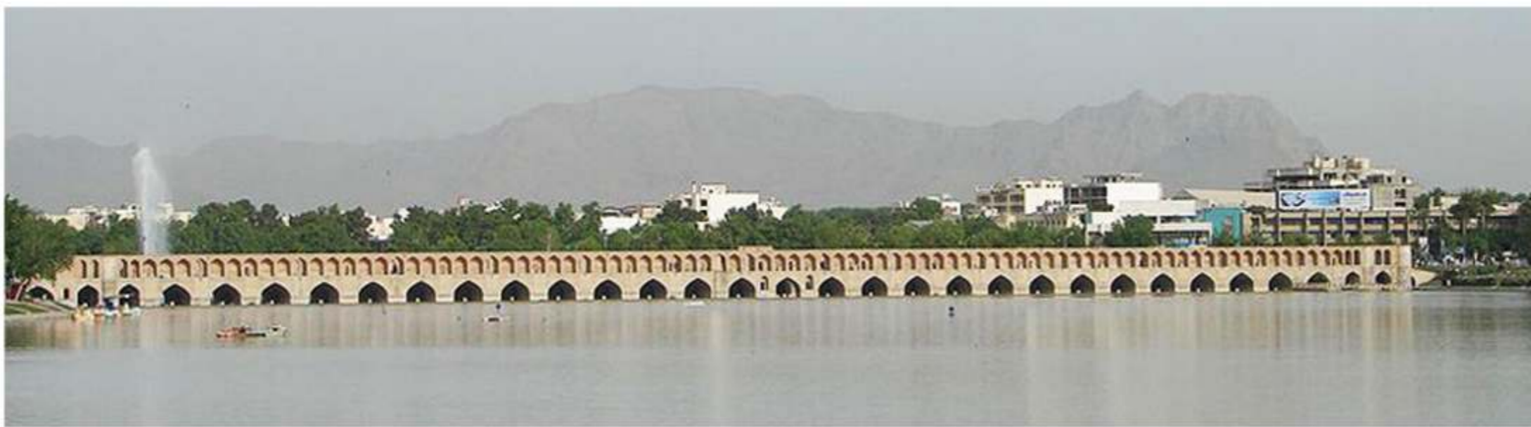
تصاویری از مفصل سی و سه پل
