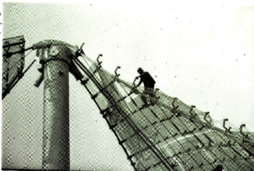
Une partie du pylône-support et le toit en construction
