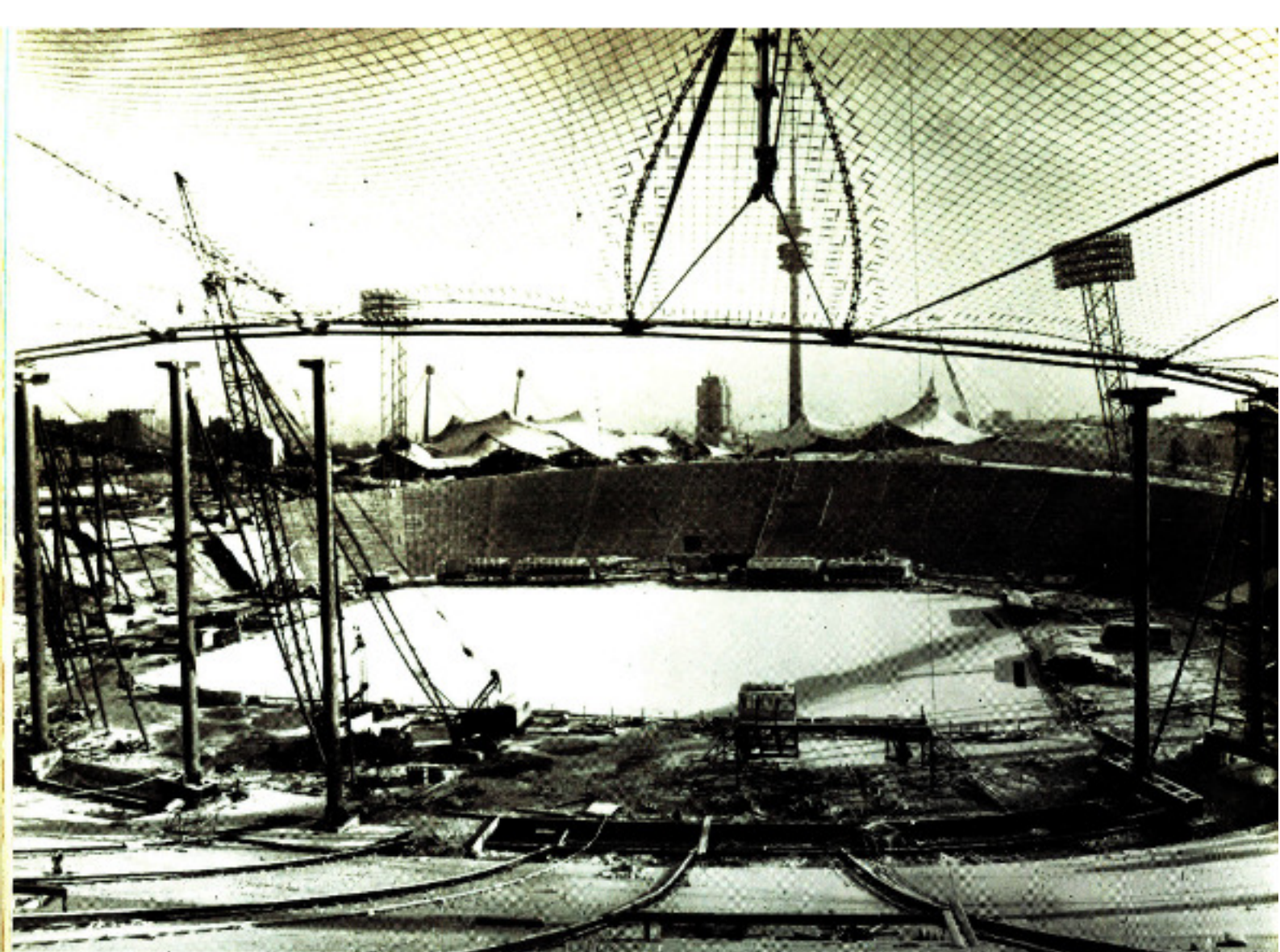
Construction du plus grand toit du monde Filet de câbles tendu couvert de verre Acryl
