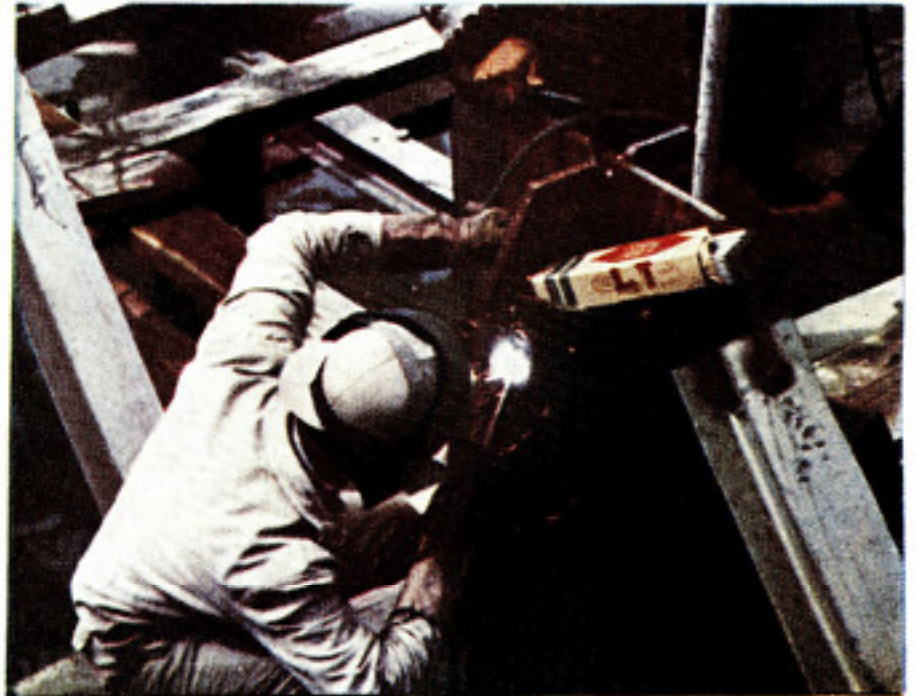
جوشکاری در اسکله سازی
