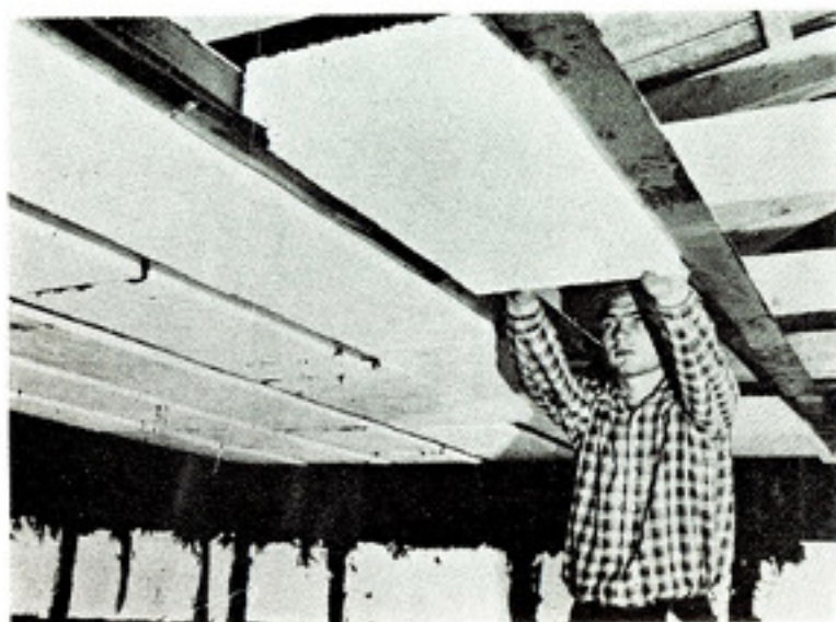
↑ نصب صفحات استیروپور در سقف سردخانه‌ها
