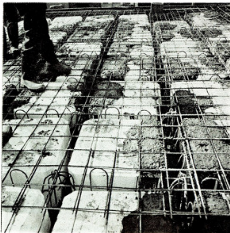
↑ نصب صفحات استیروپور در سقف سردخانه‌ها
